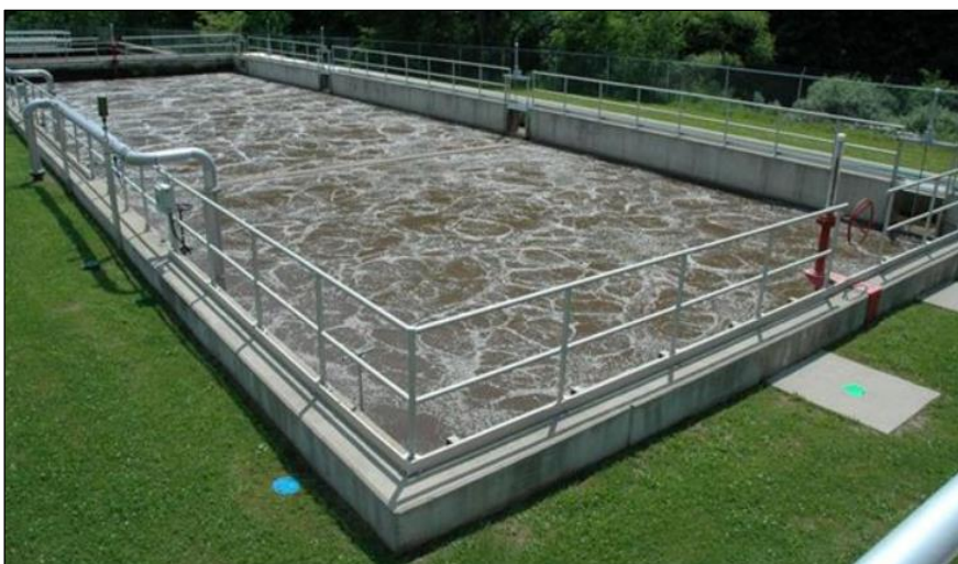
Figura 9-4: Rezervorul de aerație a nămolului activat
