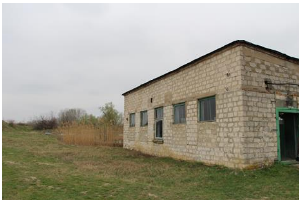
Figura 8-11: Clădirea stației de pompare SP1
