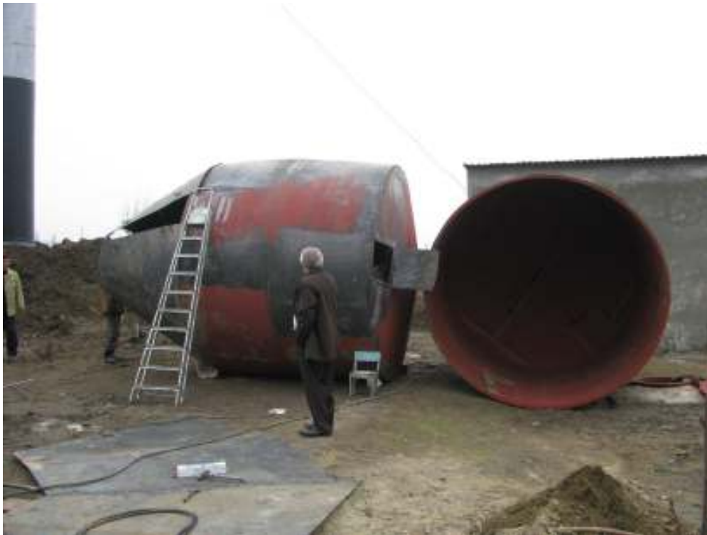
Imaginea 9: Asamblarea rezervoarelor de înmagazinare a apei
