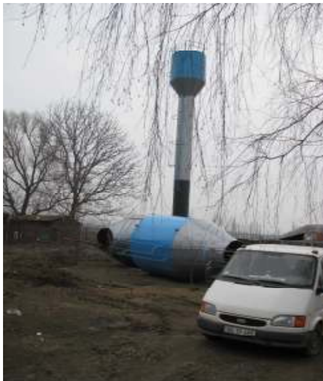
Imaginea 8: Castelul de apă de lângă puțul nr.2 realizat în cadrul proiectului FISM 2
