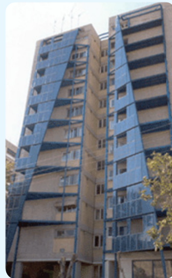
Renovarea fațadei locuințelor multifamiliale integrând fotovoltaice (Tavros, Atena). Sursa: SOURSOS
