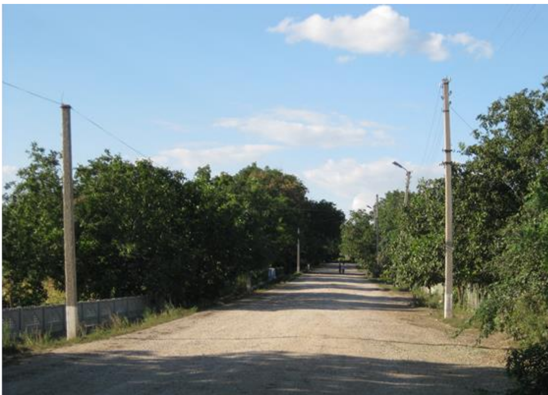
Figura 4-2: Starea stâlpilor existenți
