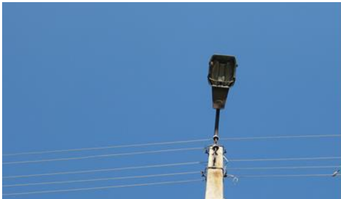
Figura 4-1: Starea corpurilor de iluminat existente
