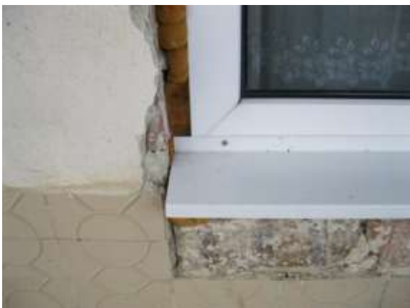
Imagine 9: Montarea pervazului
