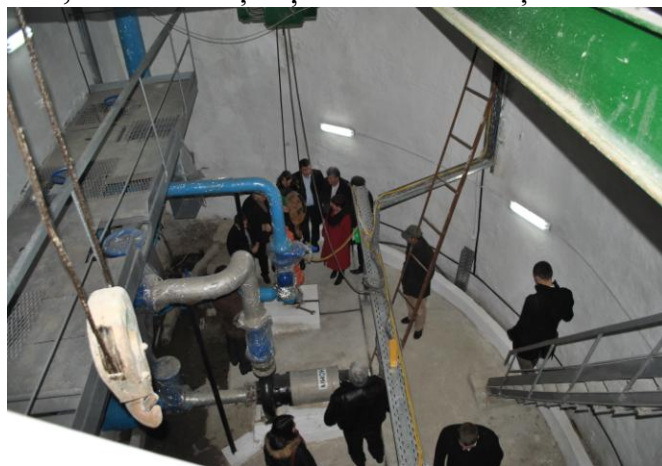
Vizita de studiu la stația de pompare, Călărași
